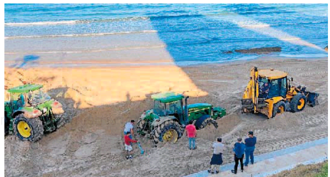
Los trabajos se realizaban ayer en la playa Santa María del Mar. :: L. V.
